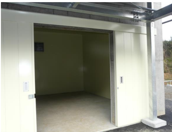
密閉試験場内部
