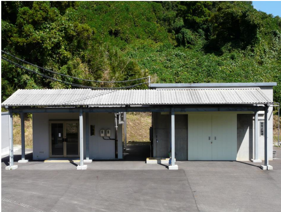
計測室（左側）及び 密閉試験場（右側）
