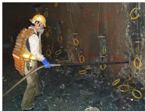
装填機による装薬風景
